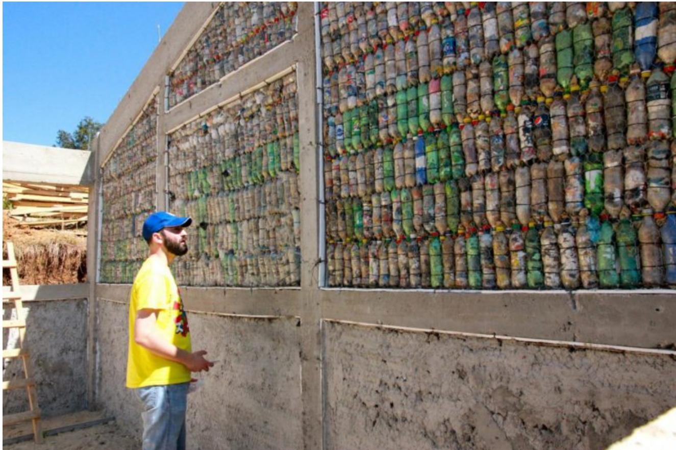
Sono già 61 gli edifici realizzati in EcoBricks, i mattoni ricavati dai rifiuti non biodegradabili.
